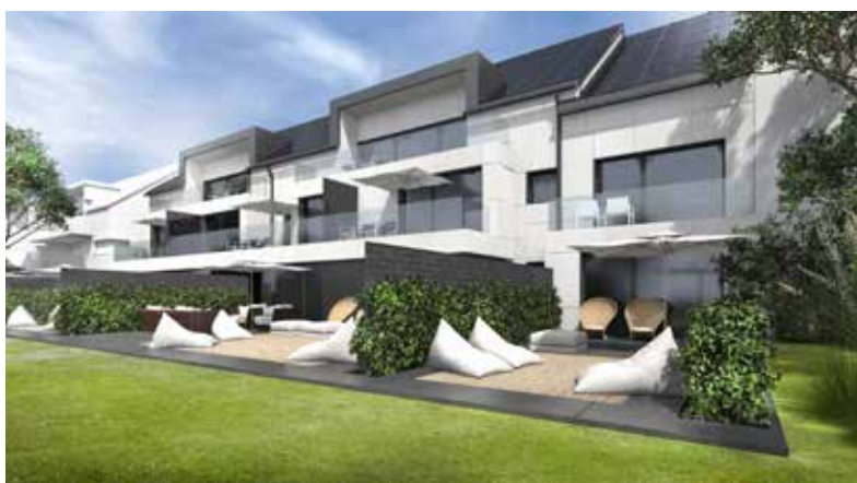
Système intégré Fullblack, les panneaux photovoltaïques assurent l'étanchéité du toit à l'eau. Promoteur: P&P Promotions - Bureau d'étude: Joris
