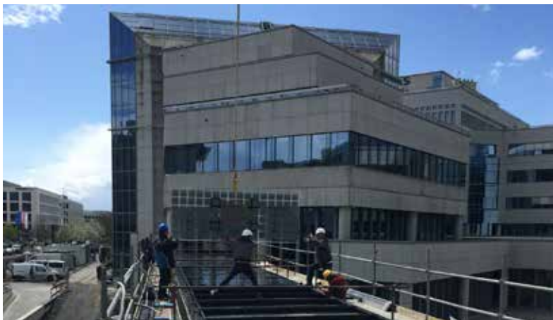
Passerelle avec panneaux sur mesure pour BNP Paribas
